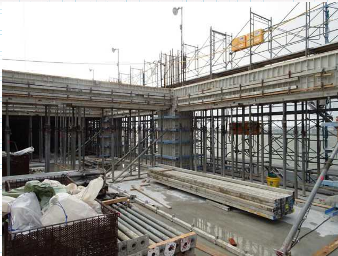
社員寮（柱・梁）
