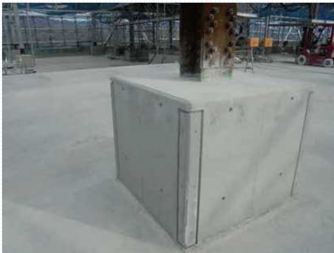
物流倉庫：鉄骨柱根巻（脱型後）
