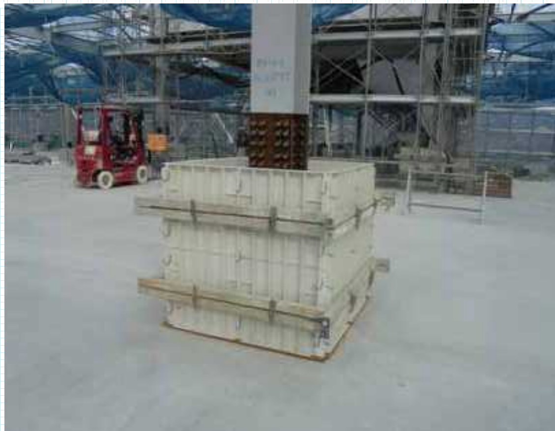
物流倉庫（鉄骨柱根巻）
