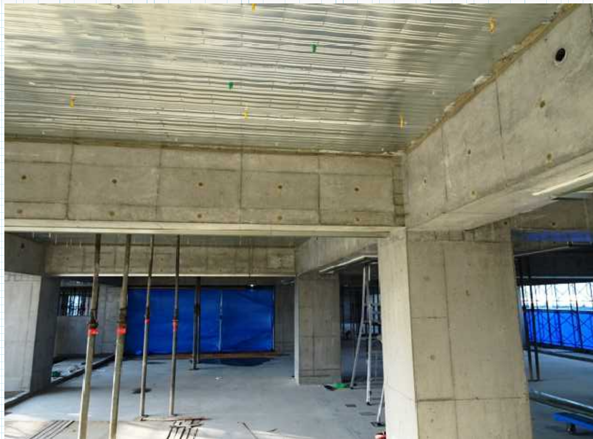
社員寮（柱・梁）：脱型後
