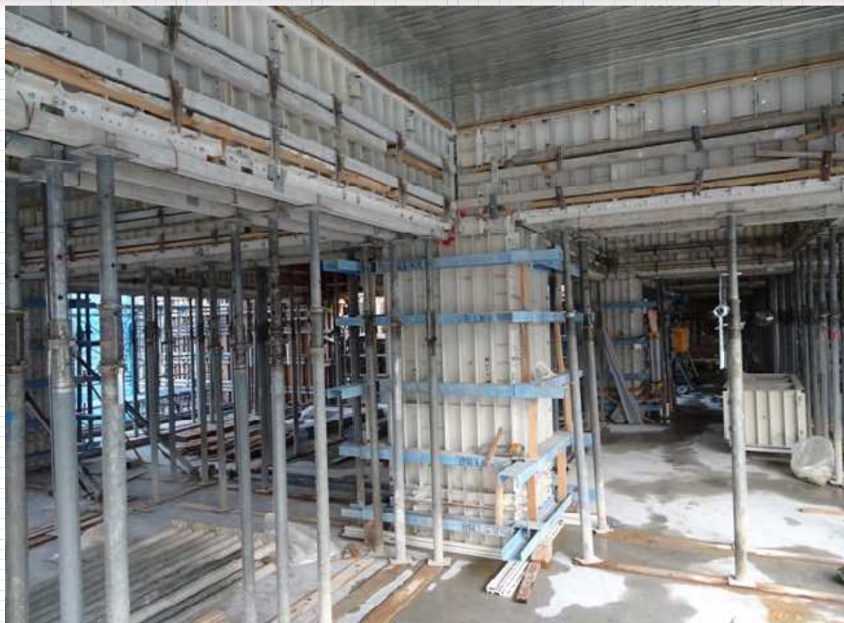
社員寮（柱・梁）
